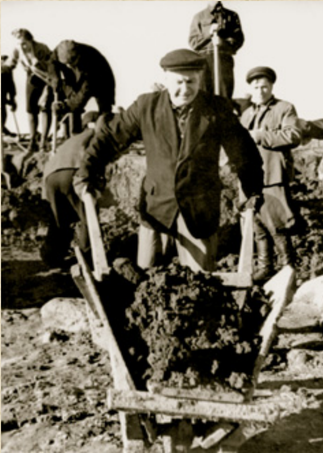
Виктор Захаров на строительстве парка. Норильск, лето 1951 г.
